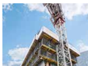
Cốp pha trượt lõi Climbing formwork
