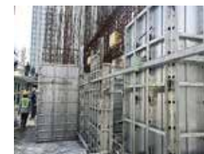
Cốp pha nhôm Aluminum formwork
