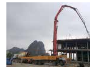
Bơm bê tông cần Concrete pump truck
