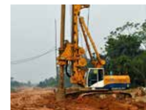
Khoan cọc nhồi Bored pile rig
