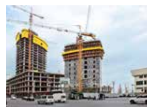
Cốp pha trượt bao che Hydraulic protection screen
