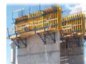
Cốp pha trượt Sliding formwork
